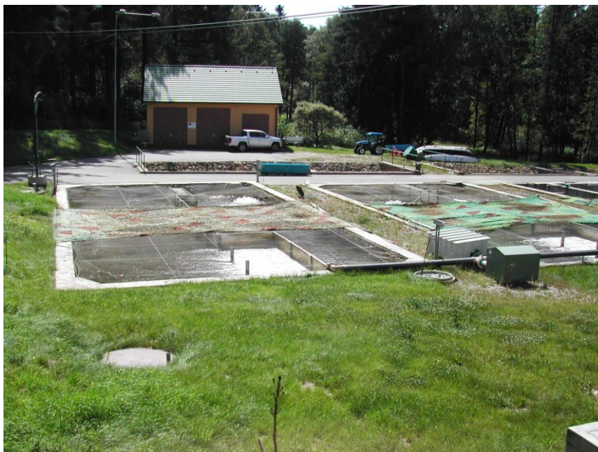
Obr. 6: Krytí systému maskovací sítí
