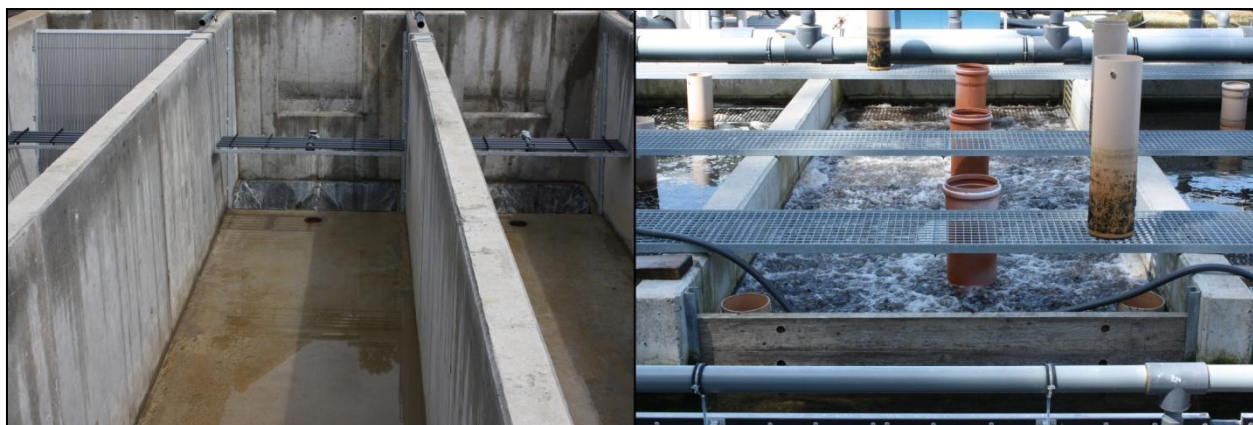
Obr. 6: Detail odchovného žlabu v odtokové části s difusérem, slovovacím otvorem a sedimentačními kužely (vlevo) a jedna z komor fixního filtru při odkalování (vpravo) na rybí farmě v Pravíkově.
